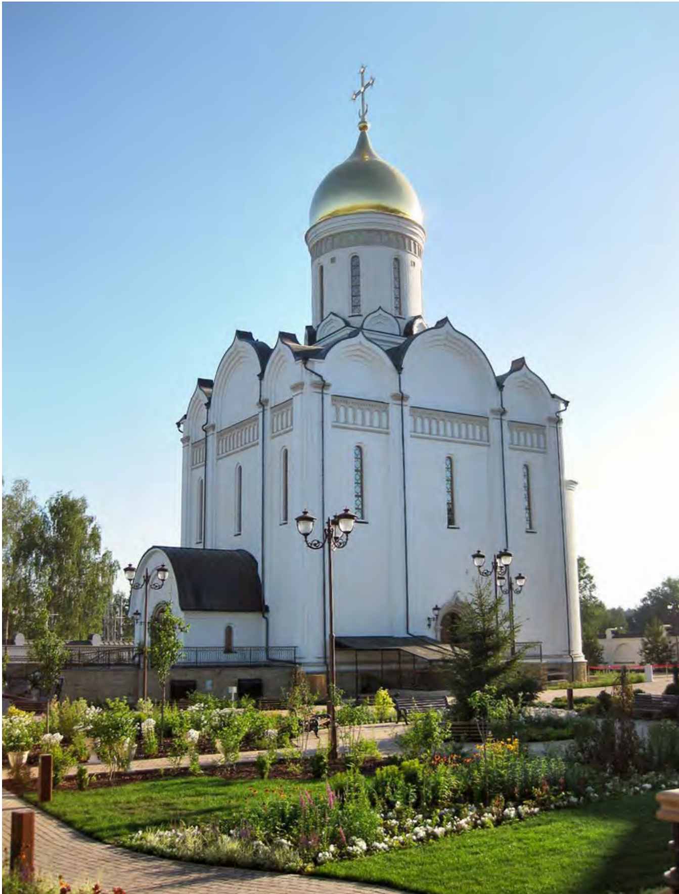
Строительство православного храма в подмосковном селе Усово профинансировала Компания «Роснефть».
