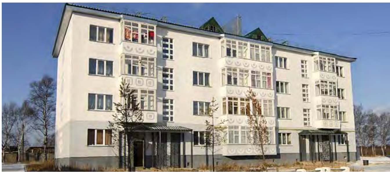
Один из домов на Сахалине, строительство которых профинансировала Компания «Роснефть».
