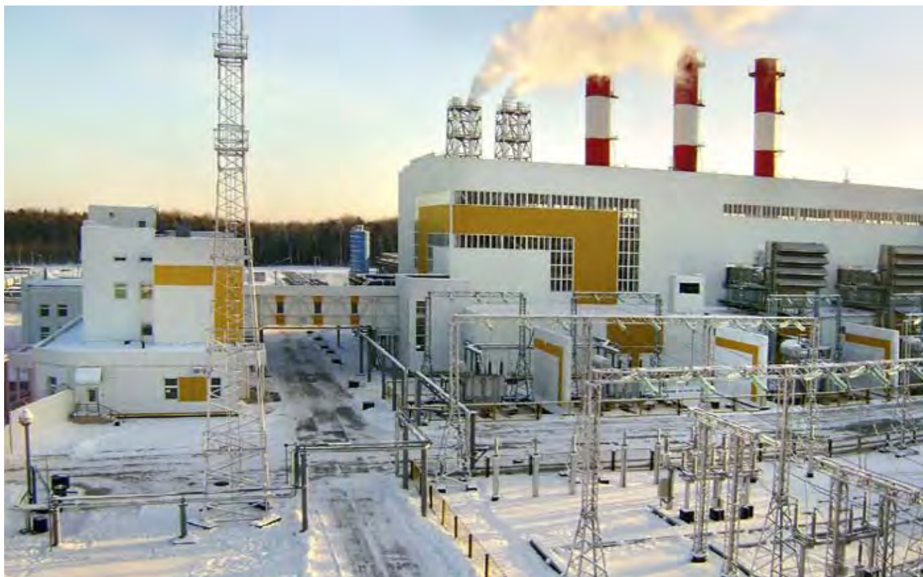
Газокомпрессорная станция на Ванкоре
